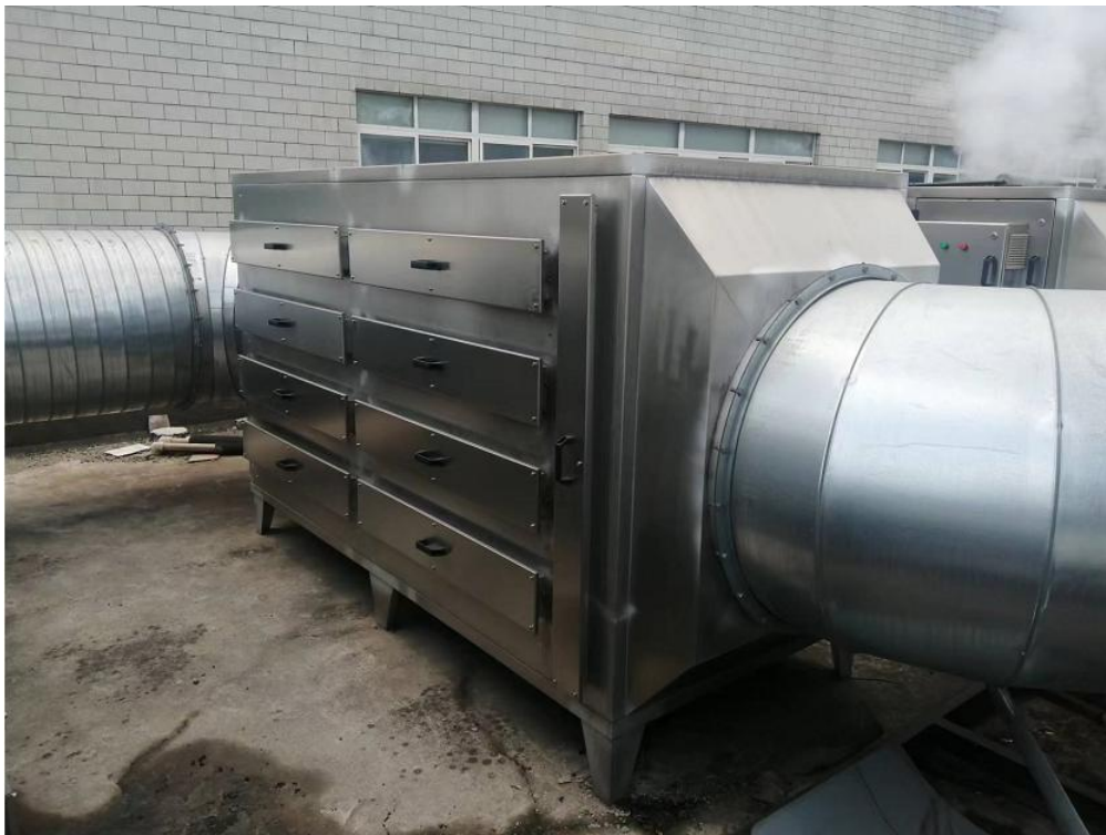
图 4.1-2b 硫化废气处理设施（活性炭）
