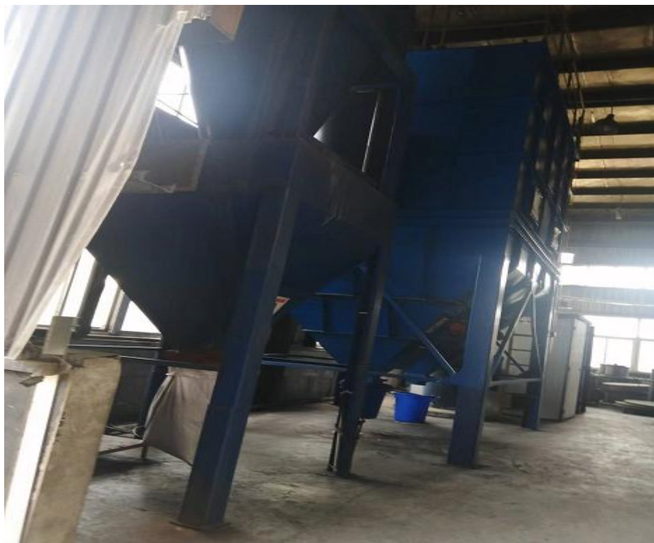
图 4.1-4 磨带废气处理设施
