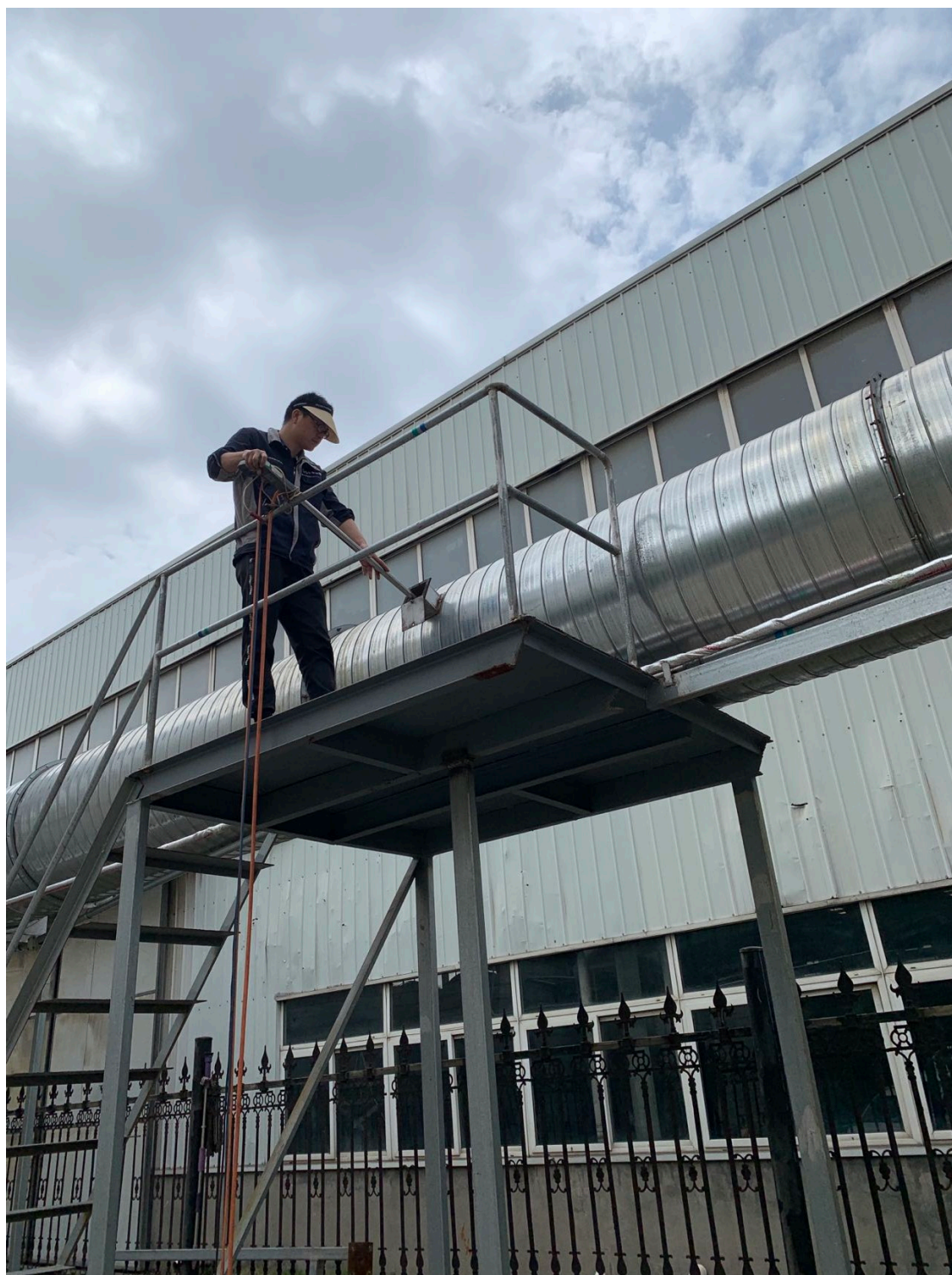
硫化废气（出口）监测取样
