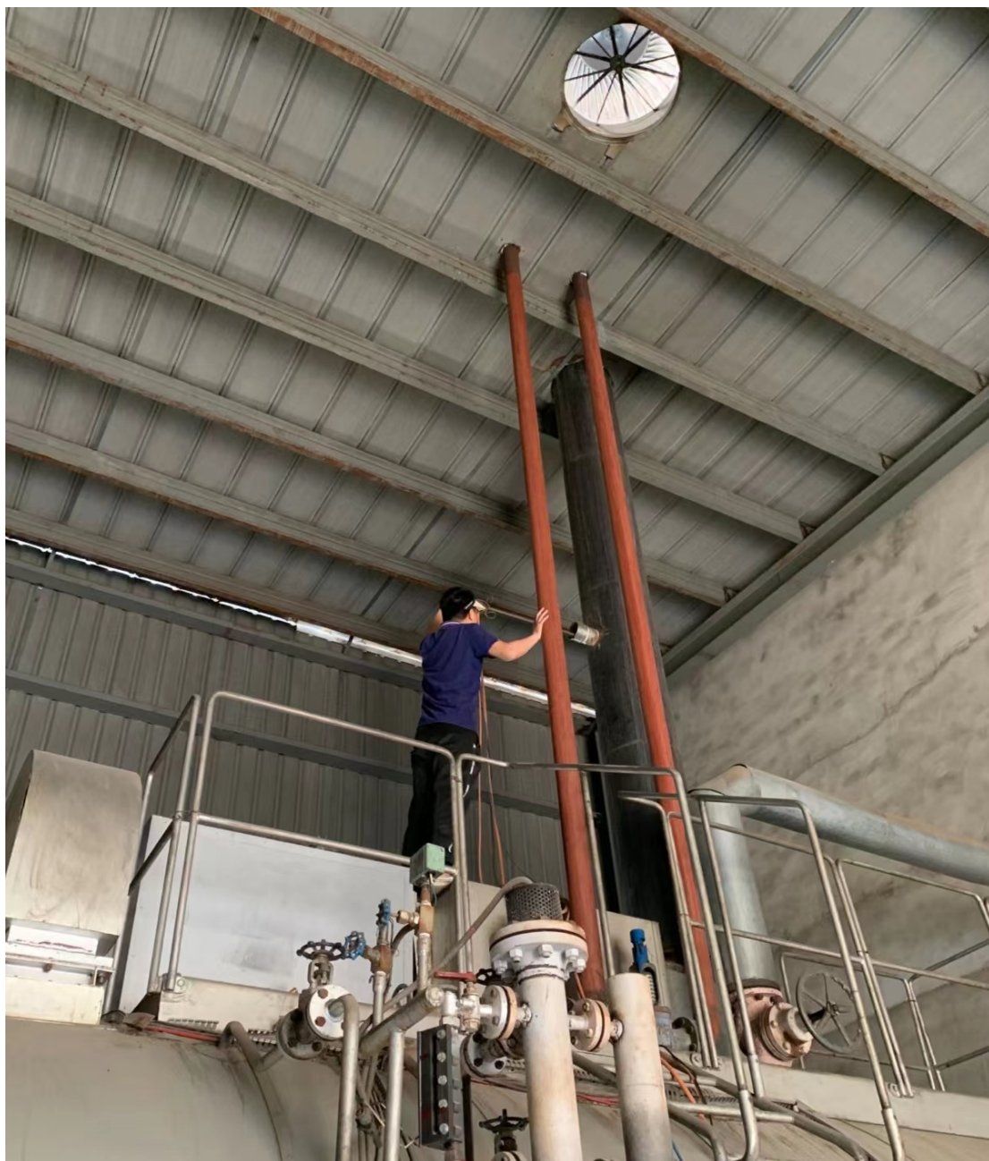
锅炉烟气监测取样
