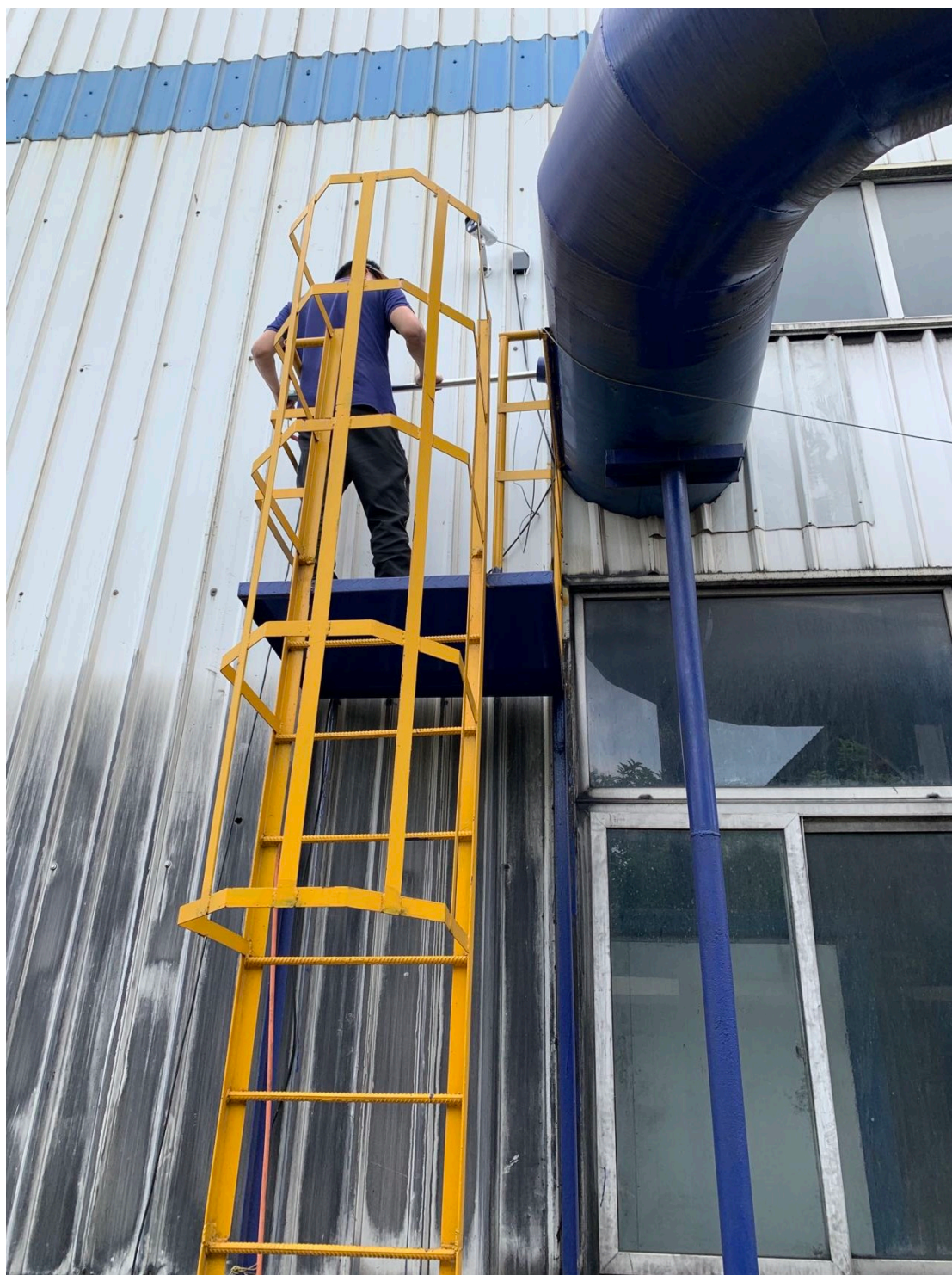
磨带废气监测取样
